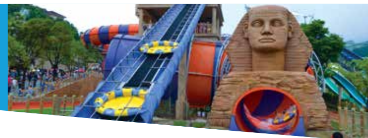
Технология Flume-thru-flume™ позволяет выполнить комбинированную установку нескольких горок
